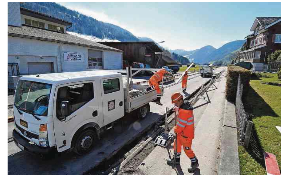
Am Dienstag starteten die Strassensanierungsarbeiten an der Kantonsstrasse in Unterwasser zwischen dem Gewerbezentrum Sändli und der Post.
